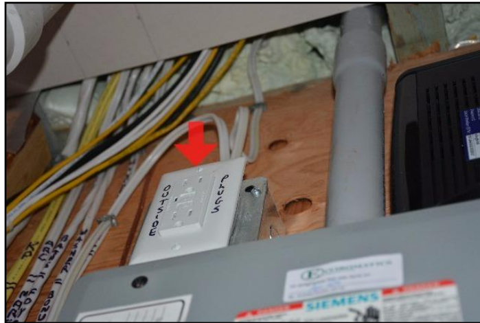
47. GFCI reset - Exterior
